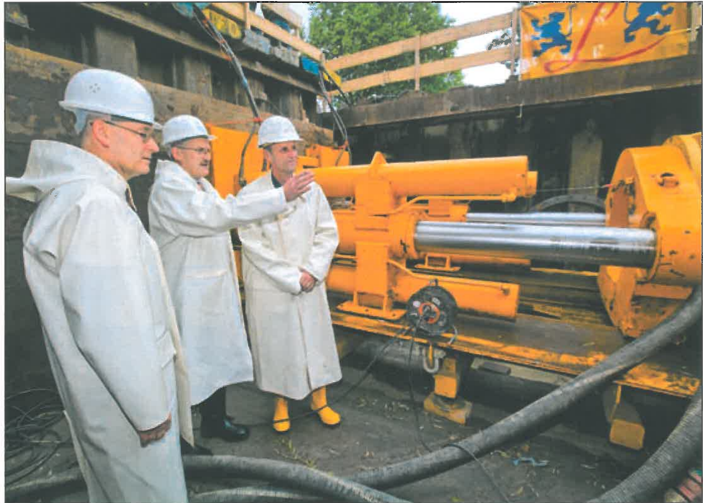
Start hoogheemraad en wethouder de boring voor een permanente waterverbinding door de Maasdijk
